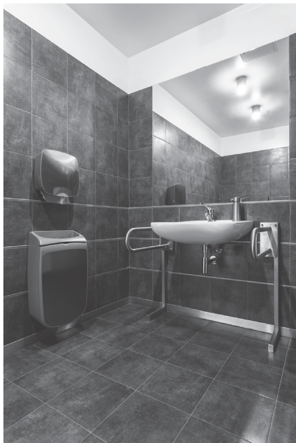
Rys. 20. Łazienki dostosowanie dla potrzeb osoby z niepełnosprawnością
