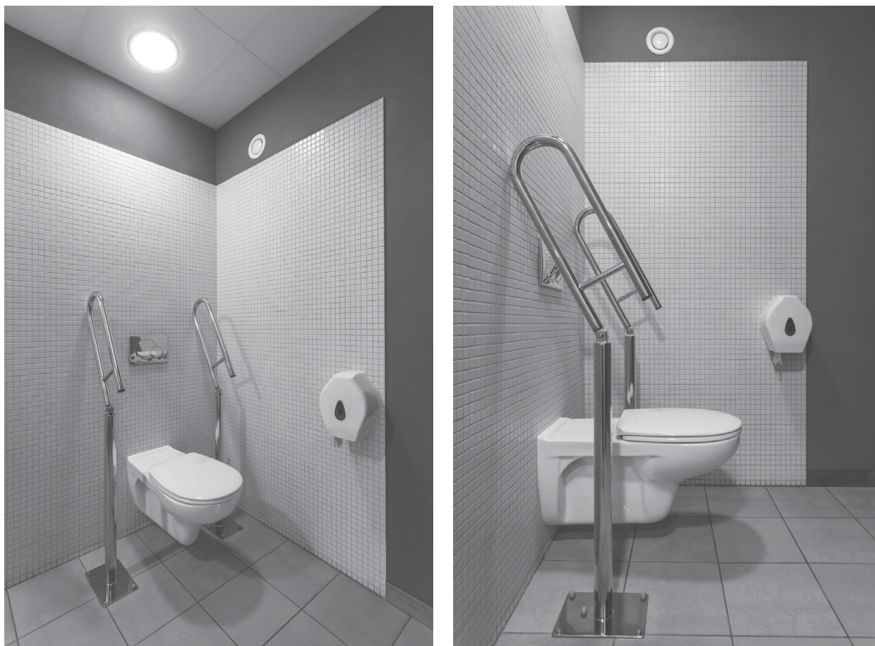
Rys. 21 . Łazienki dostosowanie dla potrzeb osoby z niepełnosprawnością
