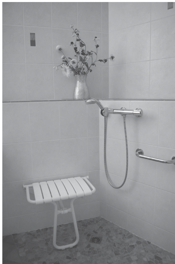
Rys. 20. Łazienki dostosowanie dla potrzeb osoby z niepełnosprawnością
